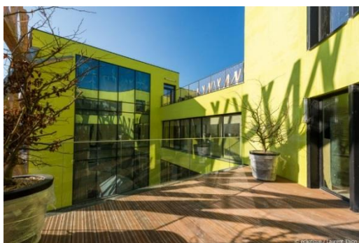
Espace culturel et de loisirs à Chaville (92). Principaux intervenants : Laraqui-Bringer Architecture, B-Ton Design, Entreprise Simonin (@Ecliptique/Laurent Thion)
