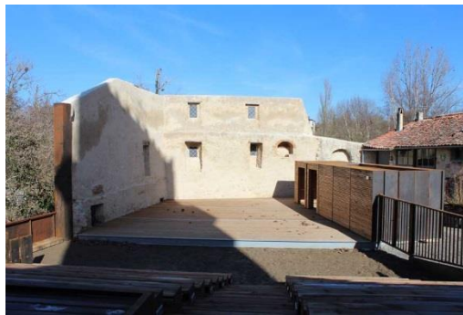
Théâtre d'été à Tourouse (09). Principaux intervenants : Sarl AB2 Architecture & Atelier Joseph, Entreprise Sèle, Entreprise Weingartner, Sarl Architecture & Paysage
