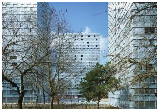
Réhabilitation urbaine à Lormont (33). Principaux intervenants : Lan Architecture, DV Construction, SCREG (@Julien Lanoo)
